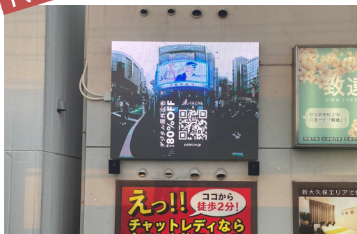
新大久保:JR新大久保駅構内 山手線外回り側 隣接ビル壁面 設置工事中写真。10月中に広告運用開始いたします。
